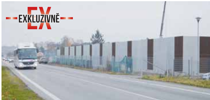
Podobné masivní a rozsáhlé betonové zdi, za nimiž se nachází rodinné domy, lze najít kromě Prostějova také například v Jihoafrické republice. Foto: archiv Večerníku
