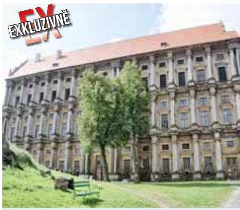
Na nádvoří plumlovského zámku by se mělo začít pracovat ještě letos. Foto: archiv Večerníku
