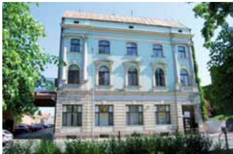
Budova domu dětí a mládeže na Vápenici se dlouhodobě nachází v havarijním stavu. Foto: archiv Večerníku
