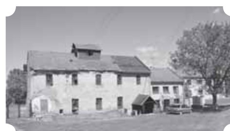
Budova bývalého mlýna rozhodně není v nejlepším stavu, obec se však nemovitost zbouarat nechystá. Foto: Martin Zaoral
