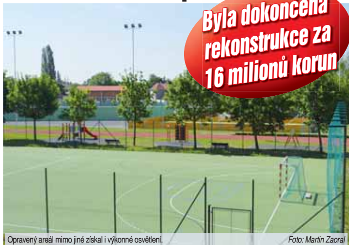
Opravený areál mimo jiné získal i výkonné osvětlení.
