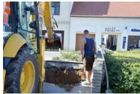
Koncem června už stavbaři vyhloubili obrovské jámy pro kontejnery ve Školní ulici. Foto: Magistrát města Prostějova
