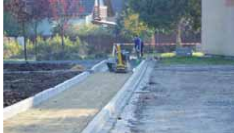
Na náměstí Odboje se budují zbrusu nové chodníky. Přibude zde i rozsáhlá sadová úprava. Foto: Magistrát města Prostějova
