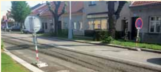
Vloni se tam nákladným způsobem dělal nový chodník, teď je Lidická kvůli opravě vodovodu znovu rozkopaná. Foto: Jiří Dostál
