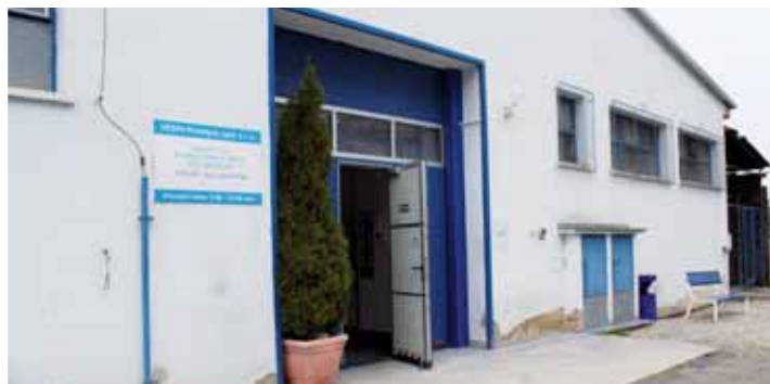
Firma Vespa byla založena v roce 1994 a stále ještě funguje v areálu Galy v Krasicích. Dveře do vybavených dílen se však bohužel minimálně na nějaký čas uzavřou. Foto: Martin Zaoral
