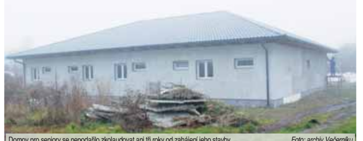
Domov pro seniory se nepodařilo zkolaudovat ani tři roky od zahájení jeho stavby.
