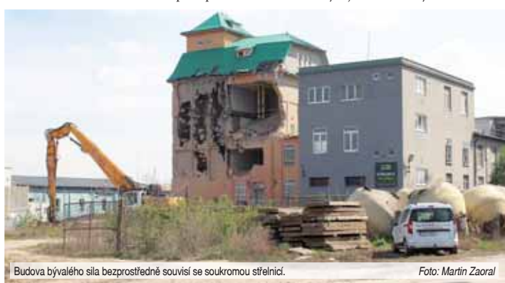
Budova bývalého sila bezprostředně souspívá se soukromou střešnicí.
