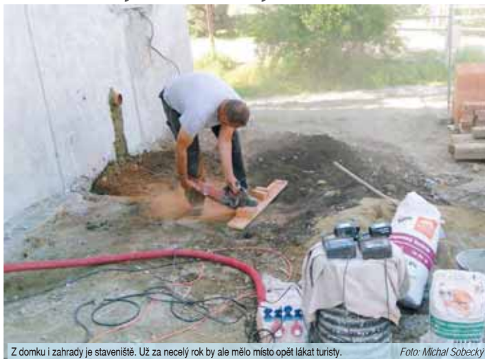
Z domku i zahrady je staveniště. Už za necelý rok by ale mělo místo opět lákat turisty.
