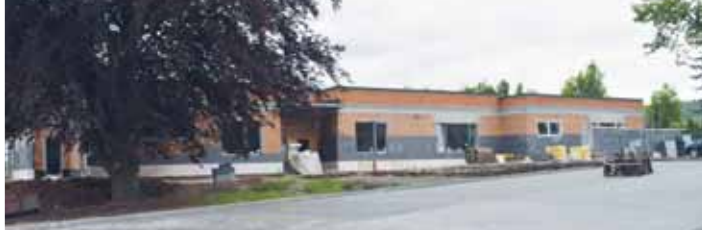
V Určicích už mají hotovou hrubou stavbu i většinu parkoviště.
