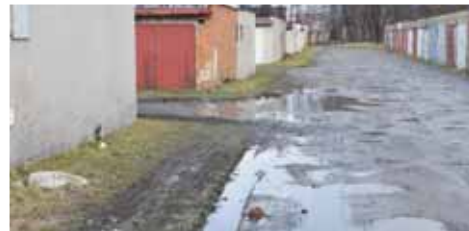
Komunikace mezi garážemi v Močidylkách je v zoufalém stavu. Město ale od oprav dává ruce pryč.
