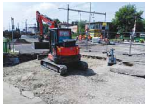
Pár hodin a bagr vytrhal prokleté koleje nevyužívané železniční vlečky slévárny Anah. Za týden už řidiči tudy budou projíždět po rovině. Foto: Michal Kadlec
