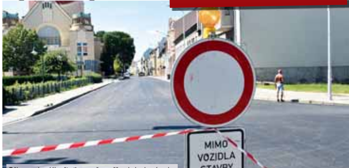
Během uplynulého čtvrtka se už vyměňovalo budoucí vodovodní dopravní značení. Vápenice se už dnes otevírá pro veškerou dopravu. Foto: Michal Kadlec
