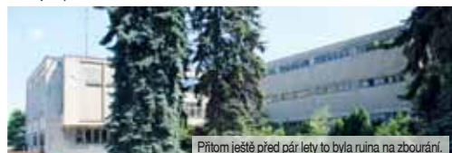
Přitom ještě před pár lety to byla ruina na zbourání.
