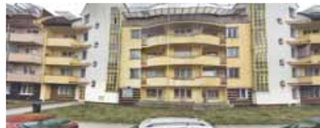
Městský dům v Norské ulici je v dezolátním stavu a po deseti letech plánovaná se v roce 2021 konečně dočká celkové rekonstrukce. Foto: archiv Večerníku
