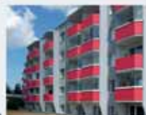
Realizace přistavěných lodžii → včetně bytů, kde dříve balkony nebyly
