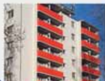
Realizace přistavěných lodžii → náhrada balkonů lodžiem
