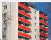
Realizace přistavěných lodžii - nahrazení balkonů lodžiem
