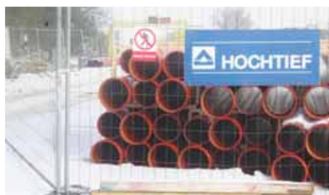
Trubky, skruže, těžká nákladní vozidla. Ohrozim čekají velké stavební manévry.
