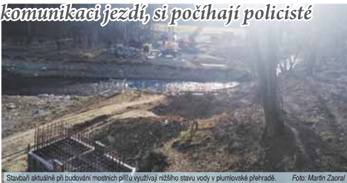
Stavbaři aktuálně při budování mostních pilířů využívají nižšího stavu vody v plumlovské přehradě. Foto: Martin Zaoral
