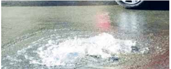
Plumlovská ulice vykazuje při deštích značné problémy s odtokem vody. Město bude u stavební firmy provádějící nedávnou rekonstrukci dvě místa reklamovat. Ilustrační foto: internet
