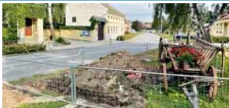
Tohle je poslední výkop v Mořicích. Po jeho dokončení byl pod zem uložen i poslední drát, který vedl v samém centru obce. Foto: OU Mořice
