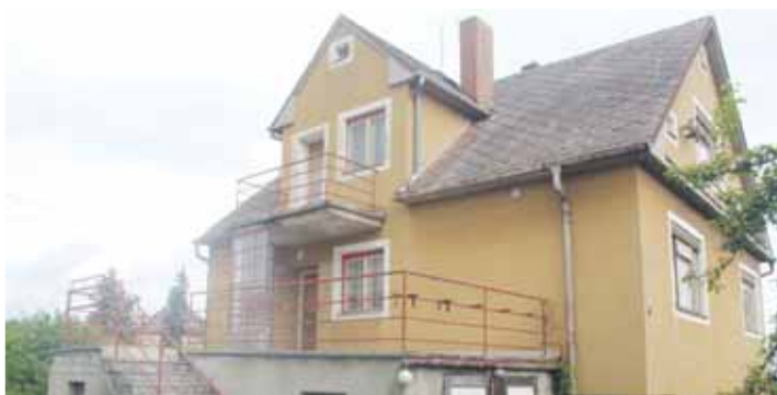
Na tento dům v Konečné ulici v Držovicích již byl vydán demoliční výměr. Rodina žijící ve vedlejším objektu se však výstavbě nových obchodů stále brání. Foto: Martin Zaoral
