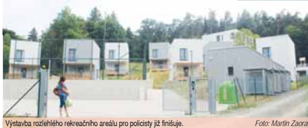
Výstavba rozlehlého rekreačního areálu pro policisty již finišuje.
