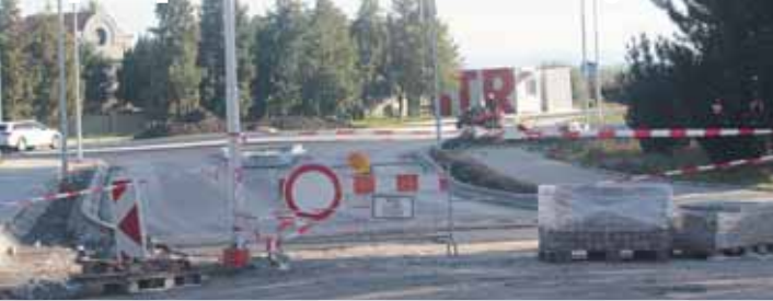
Práce v Určicích postupně pokračují a pokroky už jsou vidět.
