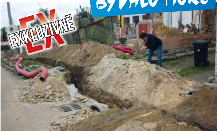
Průzkum a dokumentace při výkopech v Brodce u Prostějova.
