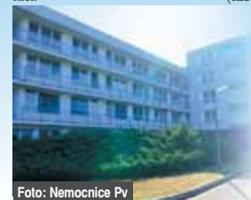
Foto: Nemocnice Pv
