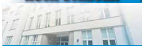
V budově Střední zdravotnické školy se letos během prázdnin malovalo a probíhala i generální rekonstrukce střechy. Foto: archiv Večerníku
